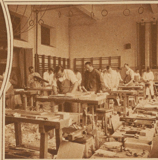
Die Schreinerwerkstatt in der Turnhalle
