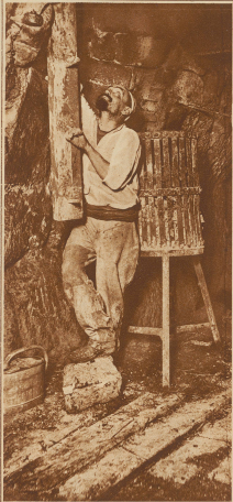
Am Ende der Abfahrtsleiter. Die unterirdischen Gänge werden durch Kohlenbecken erwärmt.
