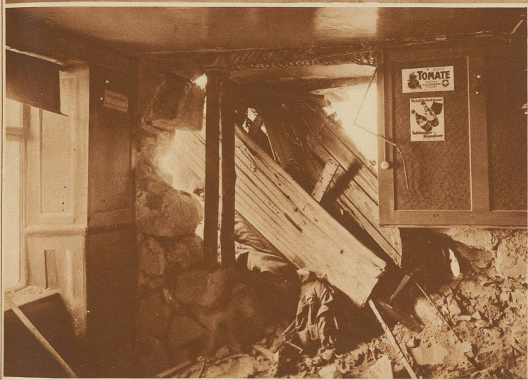
Blick in die Gaststube. Unter den Trümmern fand man die Leiche des Chauffeurs
