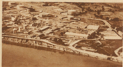
Oeltanks am Magdalenaenstrom bei Barranca Vermeja. Diese große Anlage ist durch eine über 600 km lange Rohrleitung mit der Küste verbunden, um den teuren und schwierigen Transport auf Schiffen zu sparen
