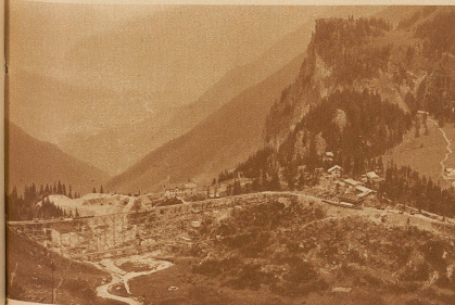
Die Staumauer auf Alp Garichte im Bau
