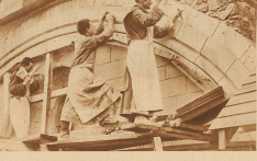
Mönche als Seebauer. Die Kirche der berühmten Benediktiner Abtei in Devon (England) wird von den Mönchen selber restauriert, da das Geld fehlt, um die Arbeit an einen Unternehmer vergeben zu können
