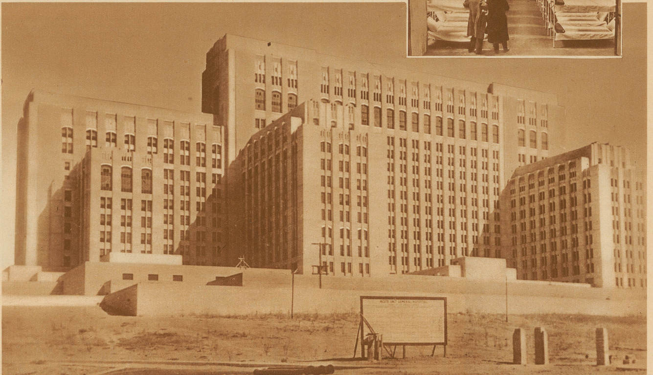
Das größte Spital der Welt ist kürzlich in Los Angeles eröffnet worden. Die Baukosten für dieses gewaltige Krankenhaus, das 3300 Patienten aufnehmen kann, betragen 60 Millionen Franken
