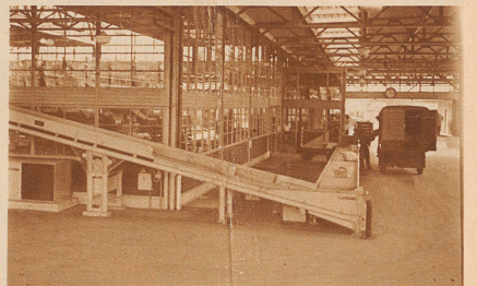
D. Im Paketraum werden die per Auto von den Filialen kommenden Pakete auf das Band gelegt und gelangen so in die Versandabteilung
