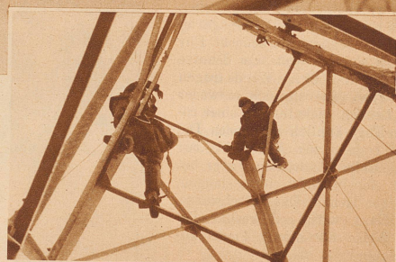
Arbeiter beim Nieten am 125 Meter hohen Funkturm
