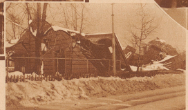
Unter der ungenutzten Schneelast, die sich letzte Woche auf die Dächer legte, brach die Konzerthalle in Neudorf-St. Gallen zusammen (The. Sauter)
