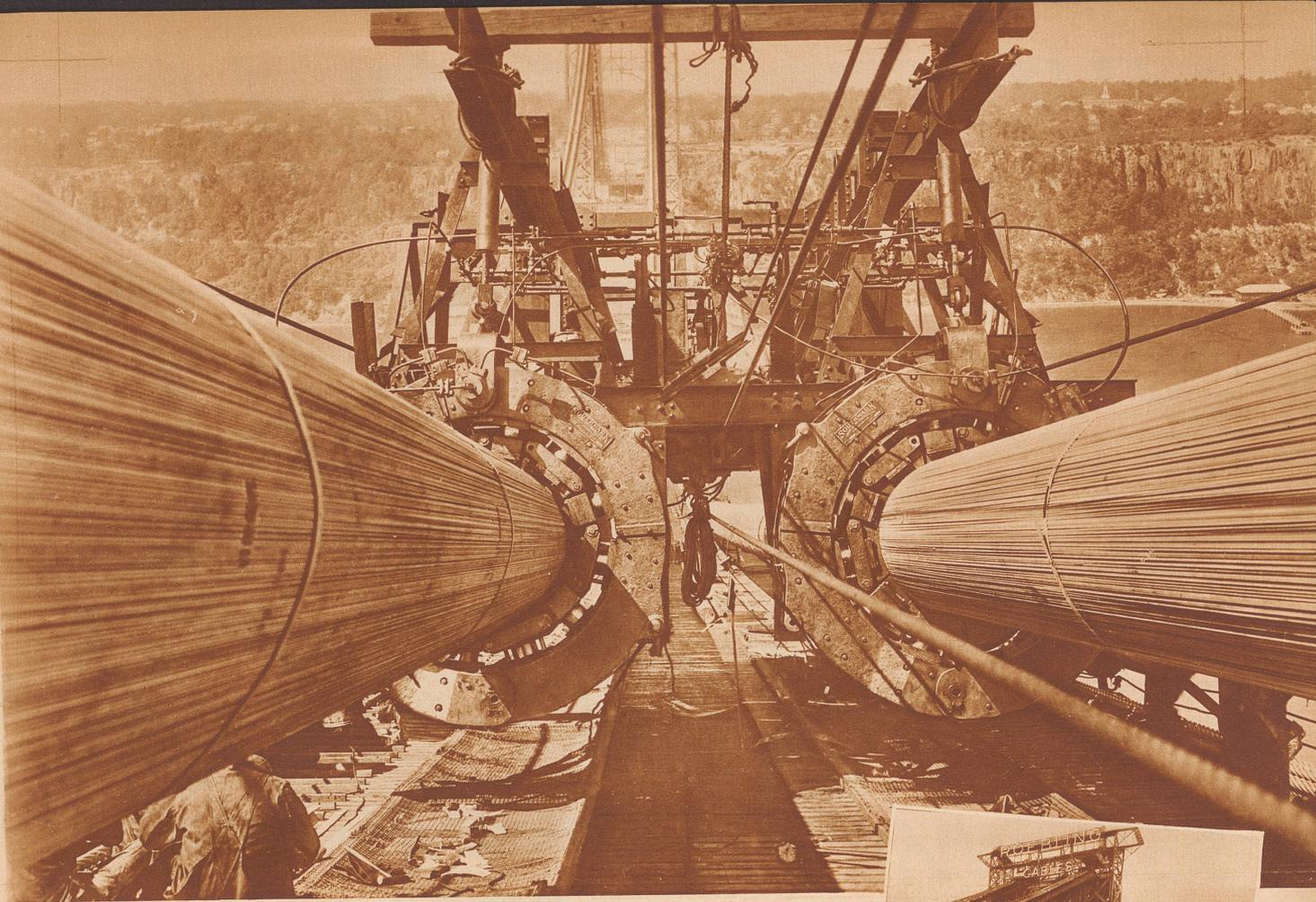
Die unerhörten Ausmaße des Werkes zeigen sich in den Hängeseilen, deren Gewicht mehr wie 30 000 Tonnen beträgt. Jedes der einzelnen Hängeseile, von denen zwei im vorliegenden Bilde sichtbar sind, besteht aus 26 474 Stahldrähten, deren Gesamtlänge pro Seil rund einmal den Erdumfang umspannt. Diese Drähte wurden zuerst in 61 Kabelstränge zusammengefaßt und durch die oben ersichtlichen Radialkompaktoren mit 600 Tonnen Druck zu dem Hängeseil von diesem bisher nicht dagewesenen Ausmaß gepreßt.
