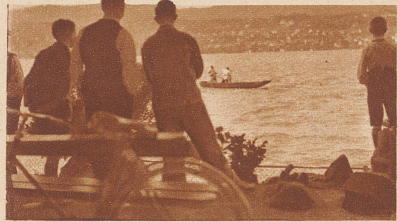
Mit Teilnahme verfolgen die Küsnachter die Bergungsarbeiten der Wasserpolizei.
