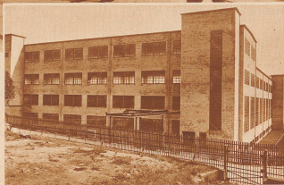
So hat die Schweizerische Maschinen- und Lokomotivfabrik, deren neue Montagehalle wir vor uns haben, ihr Bauproblem gelöst
