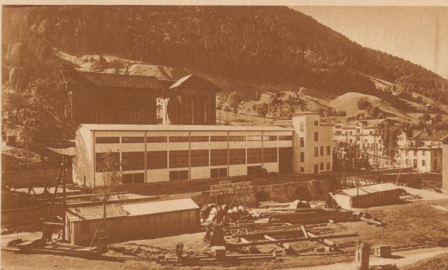
Die Zentrale des Kraftwerkes Sernf-Niederengbach in Schwanden mit daranstoßender Freiluftanlage. Die lichtdurchfluteten Maschinenräume beherbergen vier Turbinen von zusammen 37700 PS. Zwei Mann Belegschaft genügen für die Bedienung der ganzen Anlage.
