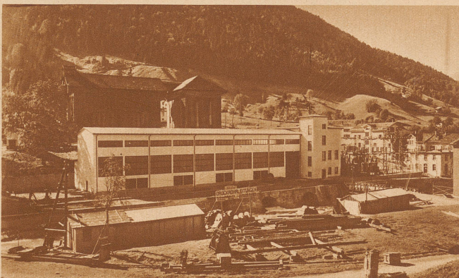
Die Zentrale des Kraftwerkes Sernf-Niederengbach in Schwanden mit daranstoßender Freiluftanlage. Die lichtdurchfluteten Maschinenräume beherbergen vier Turbinen von zusammen 37700 PS. Zwei Mann Belegschaft genügen für die Bedienung der ganzen Anlage. Fotos Schönwetter
