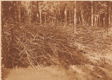
Schutzbauwerk, verankert und maskiert mit Baumzweigen und Zweigen, an der Grenze im Berner Jura
