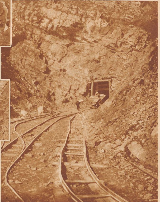
Das Südportal des Zingeltunnels. Der Tunnel wird 175 Meter lang, teilweise ausgemauert, und nach der Fertigstellung elektrisch beleuchtet
