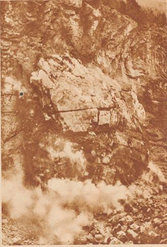
Die Sprengung riß zunächst nur den untern Teil des Felskopfes heraus. Die Hauptmasse blieb stehen. «Ist die Sache mißglückt», fragen sich die Beteiligten. Nein! Jetzt, nach etwa einer Viertelstunde poltern neue Blöcke vom stehengebliebenen Rest herunter
