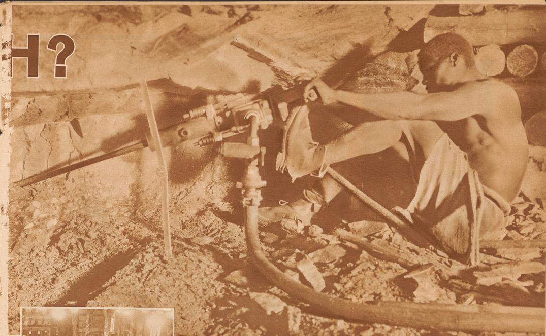
Eingeborener Südafrikaner mit dem Luftdruckbohrer an der Arbeit. Nur Schwarze können in diesen Tiefen, mehr als 2000 Meter unter der Erdoberfläche, bei der unerträglichen Hitze die schwere Bergwerksarbeit verrichten. An dem Kieselstein erkennt man die Breite des Goldreifes, welches sich auf 100 Kilometer Breite in steilem Gefälle dem Erdinneren zuneigt, so daß schon sehr schnell große Tiefen erreicht worden sind
