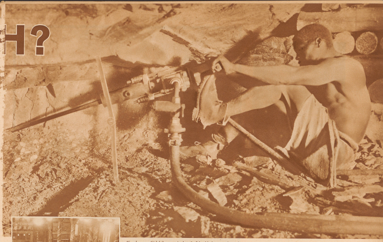
Eingebohrer Südafrikaner mit dem Luftdruckbohrer an der Arbeit. Nur Schwarze können in diesen Tiefen, mehr als 2000 Meter unter der Erdoberfläche, bei der untrüglichen Hitze die schwere Bergwerksarbeit verrichten. An dem Kieselgerüst erkennen man die Breite der Goldfelder, welche sich auf 100 Kilometer Breite in tiefen Gängen dem Erdinneren zuziehen, wo fast schon sehr schnell große Tiefen erreicht worden sind
