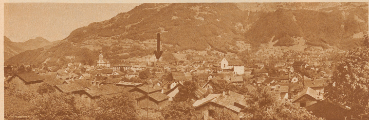
Blick auf Näfels. Im Hintergrund (Pfeil) das mächtige Dach des Freulerpalastes. Neue Bauten haben ihm die überragende Rolle etwas streitig gemacht, die dies hohe Dach unter den bescheidenen, einstöckigen Häusern des alten Näfels spielte
