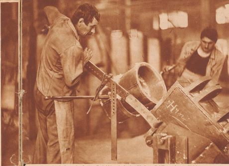
Aus dem Umarmelofen geschöpftes Metall wird hier mittels einer kipprbaren Kanne zu schweren Walzwaren gegossen
