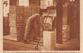
Das aus den Schmelzöfen kommende flüssige Metall wird in kleinen Gefäßen zu Büren gegossen, die man Masche nennt. Die erkalteten Masse kommt hier nach in einem Gießmaschinen, wo die Bild zeigt, aus diesem Öfen erst wird das Metall in genügender Einheitsgröße gewonnen.
