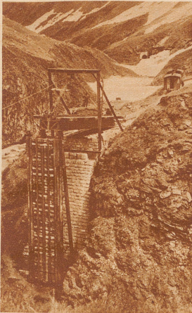
Wie die alljährliche Montage der Steffenbachbrücke vor sich geht: Der östliche Seitenteil mit dem niederhängenden Mittelstück, auf dem man das Geleise und die Zahnradspur erkennt, wird über den Brückenkopf vorgeschoben Aufnahme Feuerstein
