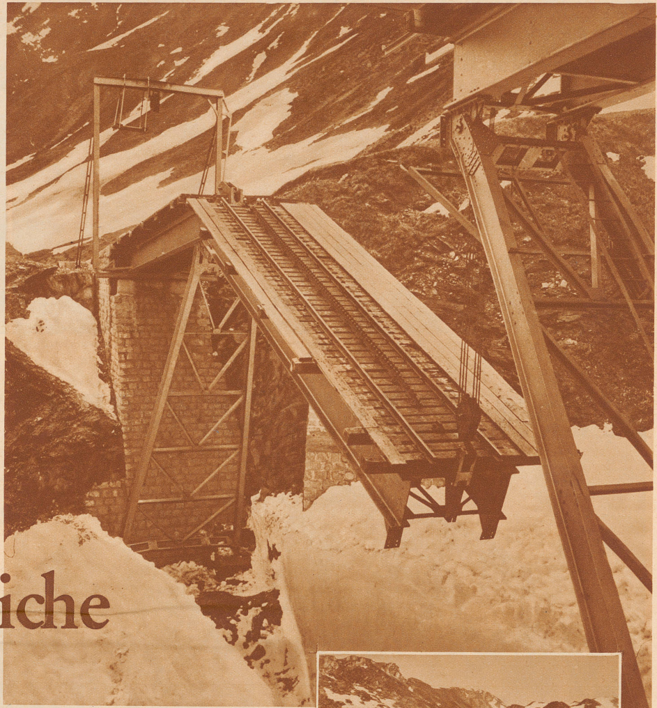
Wie die alljährliche Montage der Steffenbachbrücke vor sich geht: Der östliche Seitenteil mit dem niederhängenden Mittelstück, auf dem man das Geleise und die Zahnradspur erkennt, wird über den Brückenkopf vorgeschoben Aufnahme Feuerstein
