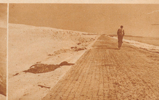
An der Krone mißt der Damm 90 Meter in der Breite. Auf dem Damm wird eine Autostraße, ein Weg für Fußgänger und ein Fahrradweg laufen. Später soll noch eine doppelspurige Eisenbahn über den Damm gebaut wer- den. Eine Fahrt über den Damm vermittelt ganz phantastische Eindrücke. Der getrocknete Sand wirkt in der Sonne weiß wie Schnee.
