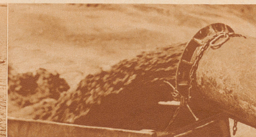
Was diesem Rohr entströmt, ist nicht Wasser, sondern Schlamm. Durch mächtige Sauger wurde der Schlamm aus dem Meeresboden entzogen und direkt dann zum weite- ren Aufbau des Damms.
