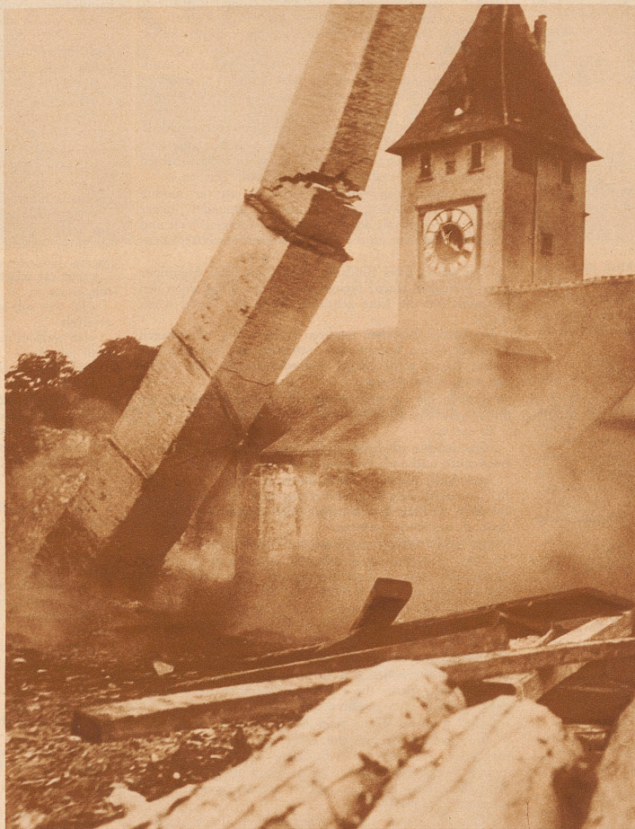
Ein Hochkamin wird umgelegt, — ein Storchhorst verschwindet
