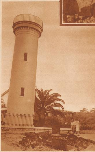
**Der gefährdete Leuchtturm von Golf Juan.** Durch Springfluten ist die Uferstraße längs des Meeres so beschädigt worden, daß der Leuchtturm von Golf Juan in gefährliche Schiefstellung geriet. Er mußte außer Betrieb gesetzt und verlassen werden, denn die Gefahr des Einsturzes besteht weiter.
