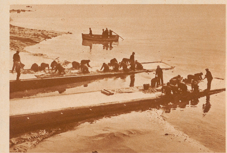
Das ist die Gleitbahn aus Eichenholz, auf der die «Normandie» ins Meer rutschte. Mit einer Geschwindigkeit von 5,5 m in der Sekunde gleitet der Riesenkörper, durch das Eigengewicht in Bewegung gesetzt, ins Wasser. Damit so ein Stapellauf ohne Zwischenfälle vor sich geht, müssen die Gleitschienen ganz gehörig eingefettet werden. Hier wurden 46 600 kg Talg und Seife zum Preise von 150 000 Franken zu dem Zwecke verbraucht.
