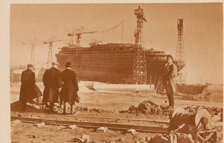
Die «Normandie» noch in der Werft, umgeben von den Riesenkranen, unmittelbar vor dem Stapellauf. Ein Heer von Ingenieuren und Arbeitern war 14 Tage damit beschäftigt, den nicht ungefährlichen Stapellauf dieses enormen Last vorzubereiten. Zu dem Gerüst, das für den Stapellauf gebaut werden mußte, wurden 2200 Kubikmeter Holz verwendet.
