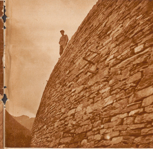
Solche Trockenmauern stehen unterwegs da, Stützbojen und Brücken. Fest und schön. Beste Arbeit. Alles vom italienischen Unternehmer gebaut für einen Betrag, der den Schweizer Straßenbauern nur ein bedauerndes Adschelzucken entlockte. So steht nun das Vierkilometer-Straßenstück da, zwischen dem armen Dörflein Spruga und dem vergessenen italienischen Talestieglein im obersten Onsernone. Jenseits der Grenze bricht die neue Straße unvermittelt ab. — Selbstlose Italiener. Erst bei uns zu bauen, ehe sie an sich selber denken!
