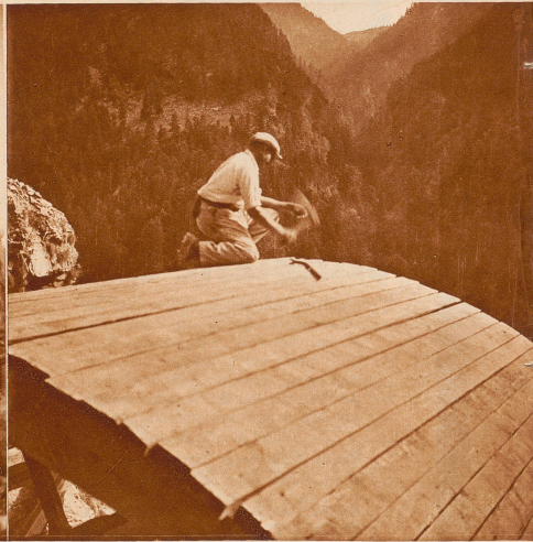
Beim Bogenbau an der neuen Straße
