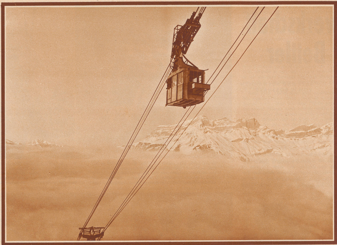
DER WEG ZUR SONNE Die Schwebbahn Engelberg-Trübsee
