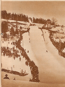
Generalansicht über die Einsiedler Sprunganlage am Frecherenberg
