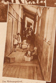
Das Wohnungsquadrat im Ruhrgebiet. Die Kinder einer Wohnfamilie in der Lorderle von Essen. Spielplatz und Aufenthaltsort für die vielen Kinder der hier wohnenden Arbeitsscheine in der Kottelberg der Bergschicht. Nicht alle sind, diese warm gepflegt, unglücklich in jeder Hinsicht, aber irgendwo müssen sich die Kinder doch aufhalten.
