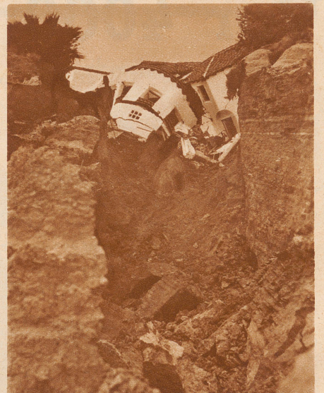
Nach der Katastrophe. Das ist das Haus des Bürgermeisters von San Clemente, einem kleinen Städtchen in Kalifornien, das von einem katastrophalen Erdbeben heimgesucht wurde
