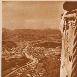
Oben am Ballonkorb vorbeigefahren. Im Hintergrund die Solothurner Jurakette. Der Einschnitt links ist der Übergang über den Fluossenen.
