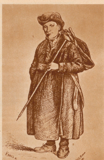
Pater Placidus a Spessa in seiner Ausrüstung als Bergsteiger. Der bergbewohnte Gernögern war ein eigener, kernsamer, und kluger Kopf, der während der 18. Jahrhunderte überflutet, sehr rasigen seine bergsteigerischen Erfolge und ungeachtet er was die erste Erstbesteigung des Piz Rusein von der Glarner Seite her betreten konnte. Diese Fahrt ist, wenn nicht der Glarner nicht schon sehr verdunkelt zeigt (Spizsonner), nicht sehr schwierig, immerhin ist Vorrecht in der Schierause der «Gelben Wand» vor Eisfall und auf dem Glarner vor Spizsonner wohl am Platze. Beliebtest, besonders seit der Eröffnung der herrlich gelegenen Planurhütte, der Wegzug. Man umgeht dabei den Kleinen Tödi nach Süden und erklettert abwechselnd Südwestwand und Westwand bis zur Spitze. Die Zugänge von Süden sind etwas länger. Man steigt entweder durch das Ruseinthal zum Ruseinliche zur Porta da Spessa oder zur Gliemspforte an. Besser ist es, von Truns aus die Ponteigliashütte zu beziehen und von dort aus über die Ponteigliashütte (am Südfuß des Piz Uräns) und die Gliemspforte von Süden her die höchste Tödi Spitze zu gewinnen. Die Schwierigkeit dieser Südabstiege hängt sehr von Zustand der Gletscher ab, sie können leicht und einfach sein, aber auch schwierig und langwierig. Ein wenig gemachter Weg ist der direkte Aufstieg von der Grünhornhütte über das Grünhorn zum Glarner Tödi. Auch die Nordwestwand und die Südwestwand können begangen werden.
