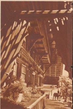
Der Berner Bauer baut sich nicht nur ein zweistöckiges, sondern auch ein schönes Haus, in ständiger traditioneller Bauweise. Ein solches Gebäu mit gepöbeltem Strohputz trägt das wuchtig überstehende Dach. Das Gebäu wurde 1798, als die Emmentaler am Land waren, von Jakob Oberli neu erbaut.
