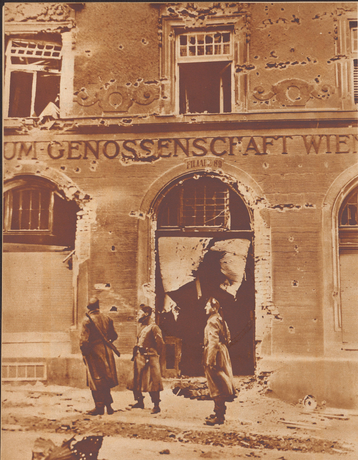
Das zerschossene Gebäude der Konsumgenossenschaft in Ottakring.
