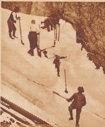
Links: Mit vereinten Kräften werden die letzten Schneemassen in der Nähe der Station Pilatus-Kulm beseitigt. Die Arbeiter stechen den Schnee blockweise ab. Jeder dieser Blöcke wiegt 2-3 Tonnen. Auf einer besonders hergerichteten Bretterbahn rutschen die gelösten Blöcke in den nächstliegenden Talkessel.
