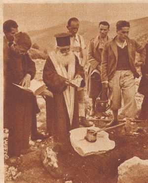
Grundsteinlegung der neuen Hütte «Helvetia» des Griechischen Alpenclubs. Der Pope segnet den Bauplatz.
