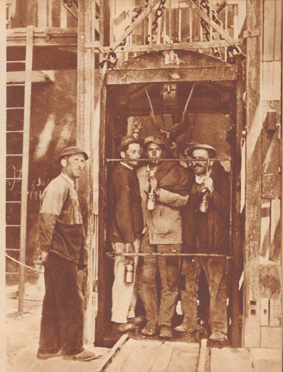
Einfahrt in den Schacht San Agustin. In fünf Minuten Fahrt hält der Förderkorb 372 Meter unter der Erde. So tief ist man bis jetzt in Almadén in die Tiefe gedrungen. Noch immer, wie vor 500 Jahren, ist die Erprobung dieselbe. Zwischen werden Blöcke geladert, die 34,5 Quecksilber enthalten.
