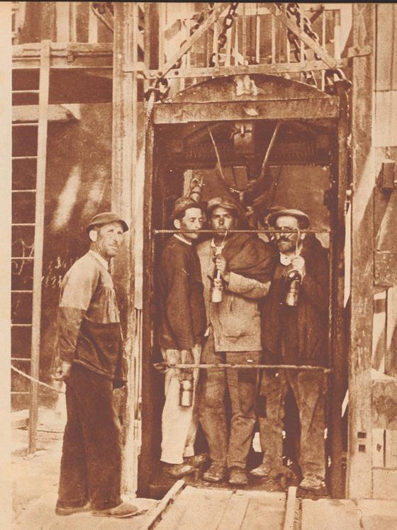
Einfahrt in den Schacht San Aquino. In fünf Minuten Fahrt hält der Förderkorb 370 Meter unter der Erde. So tief ist man bis jetzt in Almadén in die Tiefe gedrungen. Noch immer, wie vor 500 Jahren, ist die Ergiebigkeit dieselbe. Zuweilen werden Blöcke gefördert, die 35 % Quecksilber enthalten.
