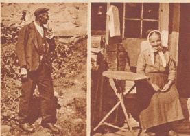
Die Geretteten des Hauses «Matta»: das Ehepaar Hans Thöny-Flüsch. Als die Lawine das Haus verschüttete, saßen die beiden auf der Ofenbank. Dieser Umstand rettete ihnen das Leben, denn der schwere Ofen schützte sie vor den einstürzenden Wänden der Stube. Sie konnten nach fünf Stunden unverletzt aus den Trümmern geborgen werden.
