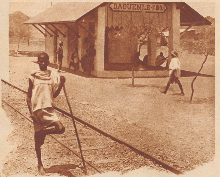
Die Station Daouenle der Franco-Aethiopischen Eisenbahn in Somaliland. Einsam steht das Stationsgebäude in der trostlosen, ausgedörrten Savannenlandschaft. Die Strecke Djibuti-Addis Abeba mißt 783 Kilometer. 90 Kilometer davon liegen auf französischem, 693 Kilometer auf abessinischem Gebiet. Die Bahn ist schmalspurig. Die Reise für die 783 Kilometer lange Strecke von der Küste bis Addis Abeba oder umgekehrt dauert drei Tage. Das heißt, während der Nacht wird nicht gefahren, sondern auf zwei größeren Stationen, wo es primitive Hotels gibt, müssen die Reisenden übernachten. Die Bahn ist nicht sehr leistungsfähig, dennoch geht der größte Teil des abessinischen Handels über diesen Weg hinaus und herein.
