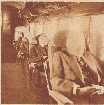
Blick in den 14plätzigen Passagierraum des Douglas-Schnellflugzeuges.
