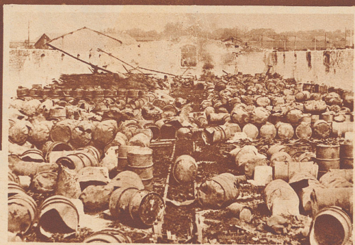
Total ausgebrannter Petrolkeller. Mehr als 1000 Oelfässer lagerten in dem Raum. Alle sind explodiert. Im ganzen sind 50 000 l Petrol, 6000 kg Benzol und 5000 l Benzin verbrannt.
