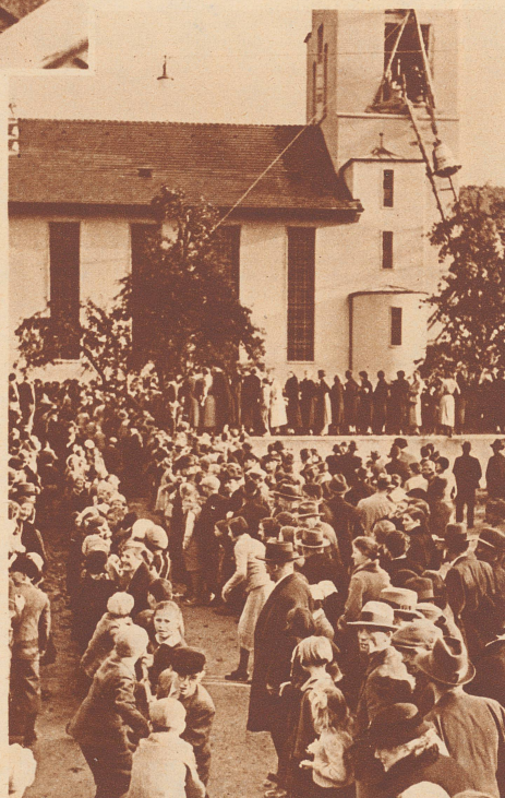
Wie der Aufzug der neuen Kirchenglocken von oben aussah. Ihr seht die vielen dicken Seile, an denen die 5337 Kilo schwere Glocke befestigt war und die dicken Holzstämme, zwischen denen die Glocken schief in die Höhe glitten. Aufnahmen Hesse
