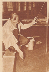
Die Ausbagger der Flußläufe des Modells erfolgt von Hand mit Hilfe einer Kelle. In den berechneten großen Gefällen werden die ausgebaggerten Mengen genau gemessen.
