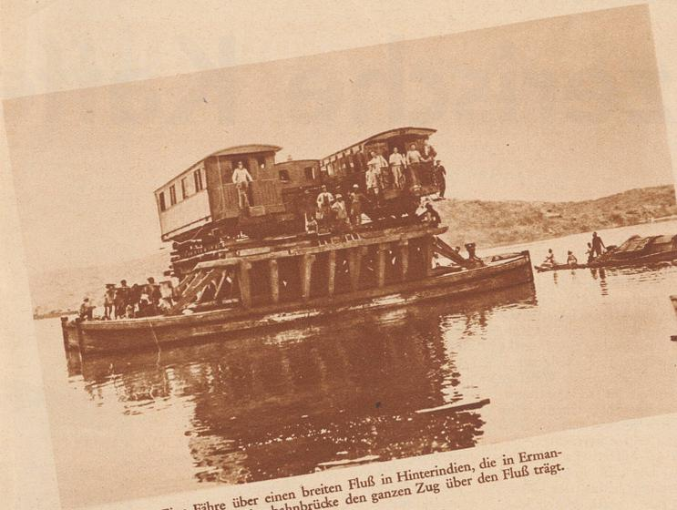
Eine Fähre über einen breiten Fluß in Hinterindien, die in Ermangelung einer Eisenbahnbrücke den ganzen Zug über den Fluß trägt.
