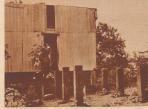
Ein Haus in der Hauptstadt Monrovia, ein Beispiel unter vielen. Die Liberianer begreifen meistens im Großen, was sie später ganz klein vollenden. Im Vordergrund sind die Zementpfeiler zu dem stattlichen Hause, das der Grundbesitzer zu bauen vorhersieht. Aber das Geld reichte nicht. Die Pfeiler blieben stehen, hinter ihnen wurde schließlich ein kleiner Weibchenversteck errichtet.
