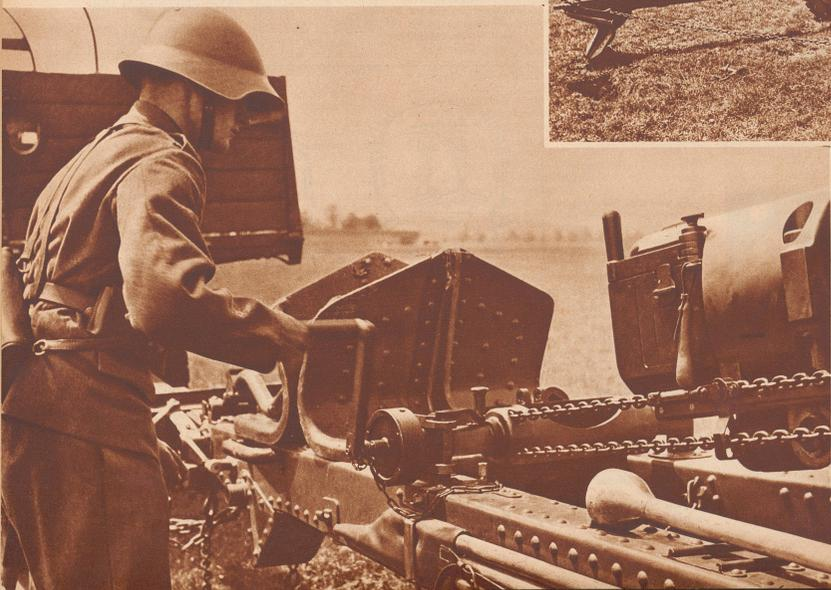
Links: Während des Marsches ruht das 1245 kg schwere und 4,4 m lange Geschützrohr nebst der Preßluftvorhol-Vorrichtung auf sogenannten Marschlagern. Zum Schießen wird das Geschützrohr mittels einer Winde und einer Kette in die Schußstellung vorgewunden. Hinten auf der Lafette sind während des Marsches die zwei je 50 kg schweren Sporne befestigt.
