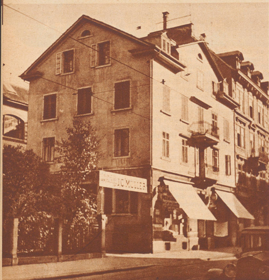
Das Haus Seefeldstraße 111 in Zürich in seinem heutigen Zustand. Es hat einen Stock mehr als der Bau, den Kammerer im Jahre 1841 hier errichtete. Es hat auch eine unruhigere Umgebung als früher, denn damals gab es keine Seefeldstraße, die Wiesen lagen vor den Fenstern, man sah bis zum See hinunter, und es war eine ungehörte Freude, aus den Schwefelschnitten-, Zündhölzli- und Hustenbonbons-Werkstätten heraus ins Grüne zu kommen. Aufnahme Staub
