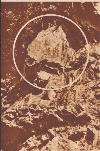
Im Korb: Der lockere gewaltige, gefährlichste, im letzten Gleichgewicht liegende Felsblock an der Metallhah vor der Sprengung. Er ist fast 900 Kubikmeter groß. Im Block ist deutlich der Korb zu erkennen, durch den er im Lauf der Zeit von der Fluh abgerollt wurde. Am Fuße des Blockes sind zwei langgestreckte Minen zum Bestehen, die Sprengladung enthalten.
