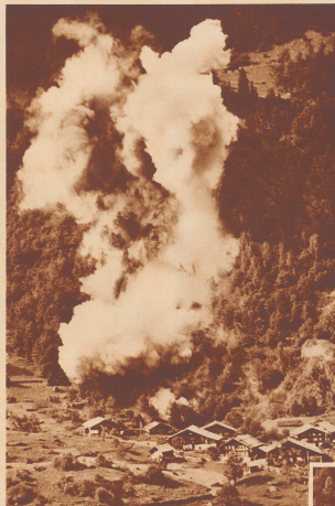
15 Sekunden später: Die Sprengung ist vollzogen. Der Block ist geborsten. Mit dampfendem Gestein strömen die Felsenmassen über die in eine dicke Staubwolke gefüllte 200 Meter hohe Wand zu Tal. Mancher Baum fällt, der verbleibende Laubwerk zum Opfer. Die gefährdeten Häuser auf dem Meisboden, die vorübergehende vor der Sprengung gestanden worden wären, sind nicht mehr zu sehen. Nur ein paar laubtragende Sprößlinge folgen in ihre Höhe, und einer kleine Stoppel Baum auf der Schindeldachfläche.
