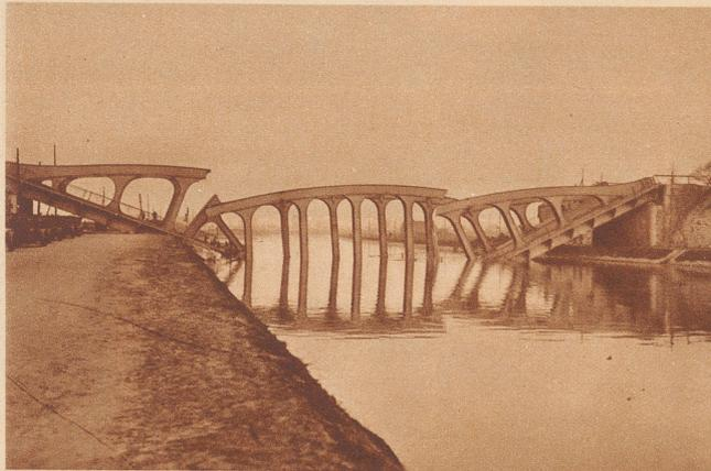
**Brückeneinsturz.** Wahrscheinlich infolge eines Konstruktionsfehlers ist die kürzlich erbaute Brücke über den Albert-Kanal bei Hasselt in Belgien eingestürzt, als eben ein Tram darübergefahren war. Menschen kamen nicht zu Schaden.
