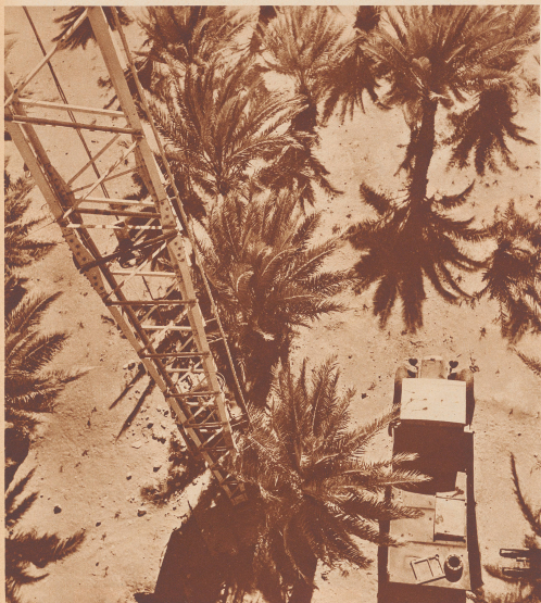
Zum Überqueren der vier großen Wasserläufe Euphrat, Tigris, Jordan und Orontes wurden die Leitungen von einem in Höhe eingetaucht, im Flußbett verankert oder an hohen Eisenkammern mit 18 bis 24 m Höhe geföhrt. Erstere in beim Jordan und beim Orontes der Fall, letztere beim Euphrat und beim Tigris. Das Bild zeigt, mitten in den Palmen stehen, einen 40 Meter hohen Lattenmast für Halfta in Ostjordan. Das Euphrat, wo die Rohre auf eine Höhe von 800 Metern frei in der Luft hängen.
